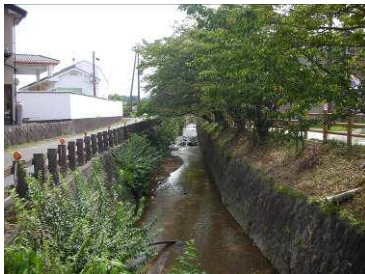
集落の西側境界を流れ国道西側の農地と見瀬池を潤す高取川（見瀬池から）
